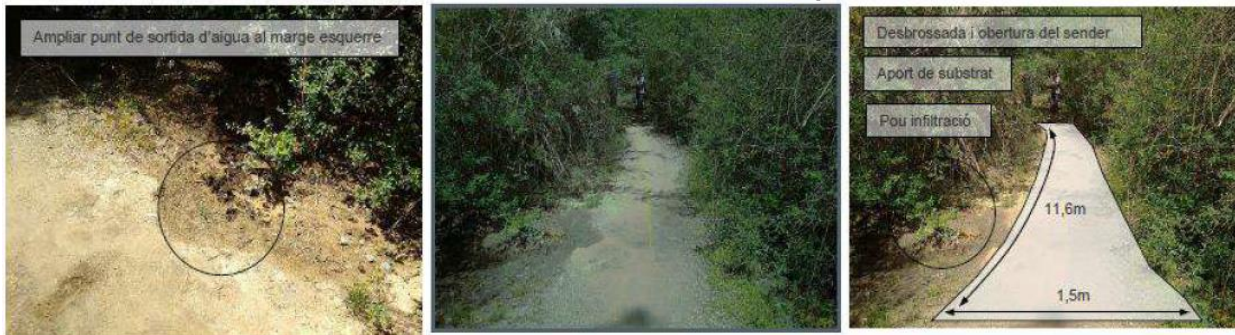
TRAM 6. Obertura del sender, millora del ferm i gestió de l'escorrentiu
