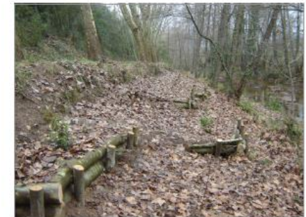
Palissada executada per Naturalea
